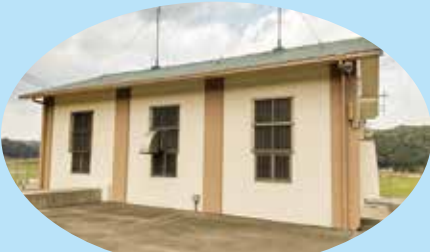
発電機場外壁塗装
