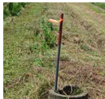
給水栓を確認し目印を付けるなどの対策をお願いします!!
