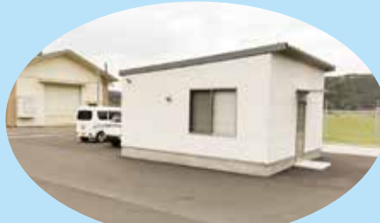
資材倉庫建設
