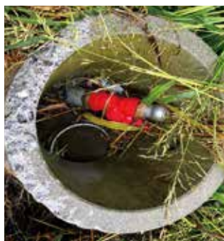
破損した給水栓
